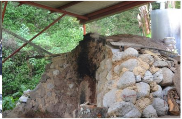
〈ブギアス町、昨年建設された木酢施設〉
